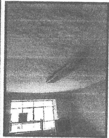
Vigas y pisos flexionados / Falso cielo raso deteriorado por la humedad
