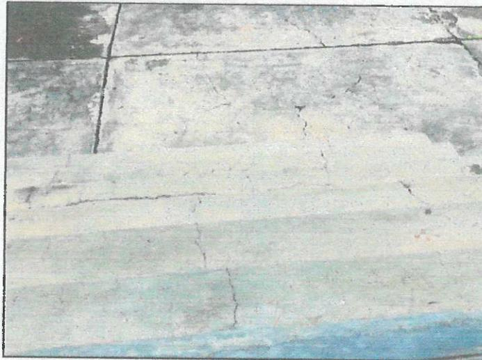
Fotografía 6. Fisuras y agrietamientos de la losa deportiva ubicada entre los 3 pabellones inspeccionados.
