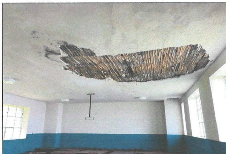
Fotografía 3. Filtraciones de humedad y caída de cobertura de techo.
