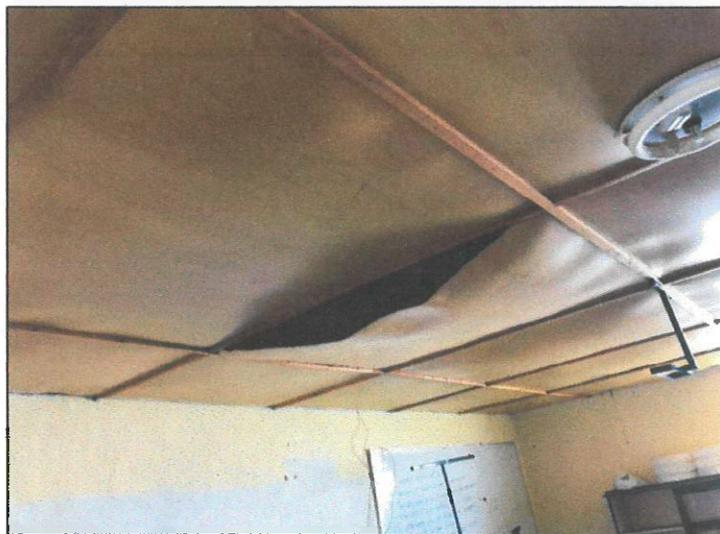
Fotografía 4. Filtraciones de humedad en los interiores de los ambientes.
