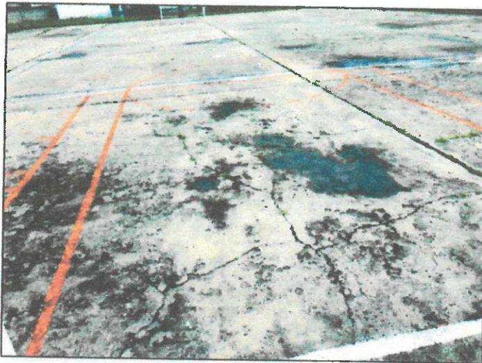
Fotografía 7. Fisuras y agrietamientos de la losa deportiva, detrás de los pabellones inspeccionados.
